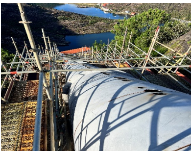
Sustitución tramo tubería forzada 140m, D2200mm. CH Castrelo
