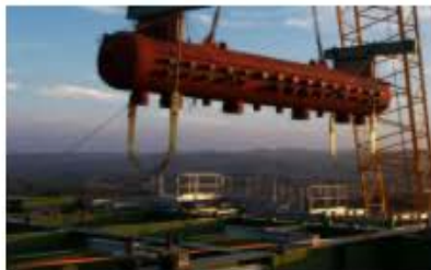
Montaje Caldera de Recuperación
