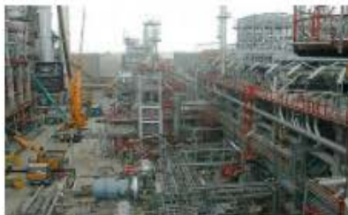
Montaje Unidad Hidrodesulfuración
