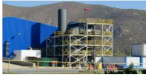
Almacenamiento concentrado de cobre
