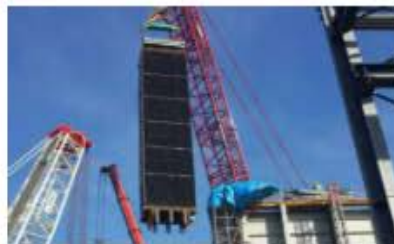
Montaje Caldera (HRSG) Ciclo Combinado
