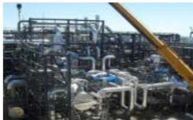
Montaje BOP de la isla de potencia Planta termosolar
