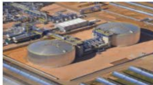
Ingeniería, suministro y montaje de 2 Tanques de sales fundidas de 16.300m 3 de capacidad
