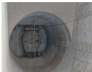
Rehabilitación integral Turbina Francis. CH Cañaverosa
