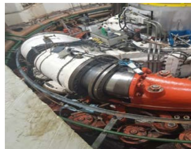
Revisión grupos y válvulas. CH Villarino
