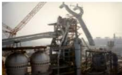
Remodelación Hornos Altos 5 y 6
