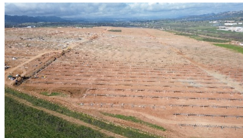
PFV Rocinante-Puertollano (Ciudad Real)
