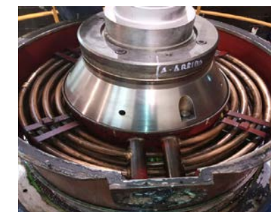
Desmontaje y Montaje completo G1. CH Linares del Arroyo
