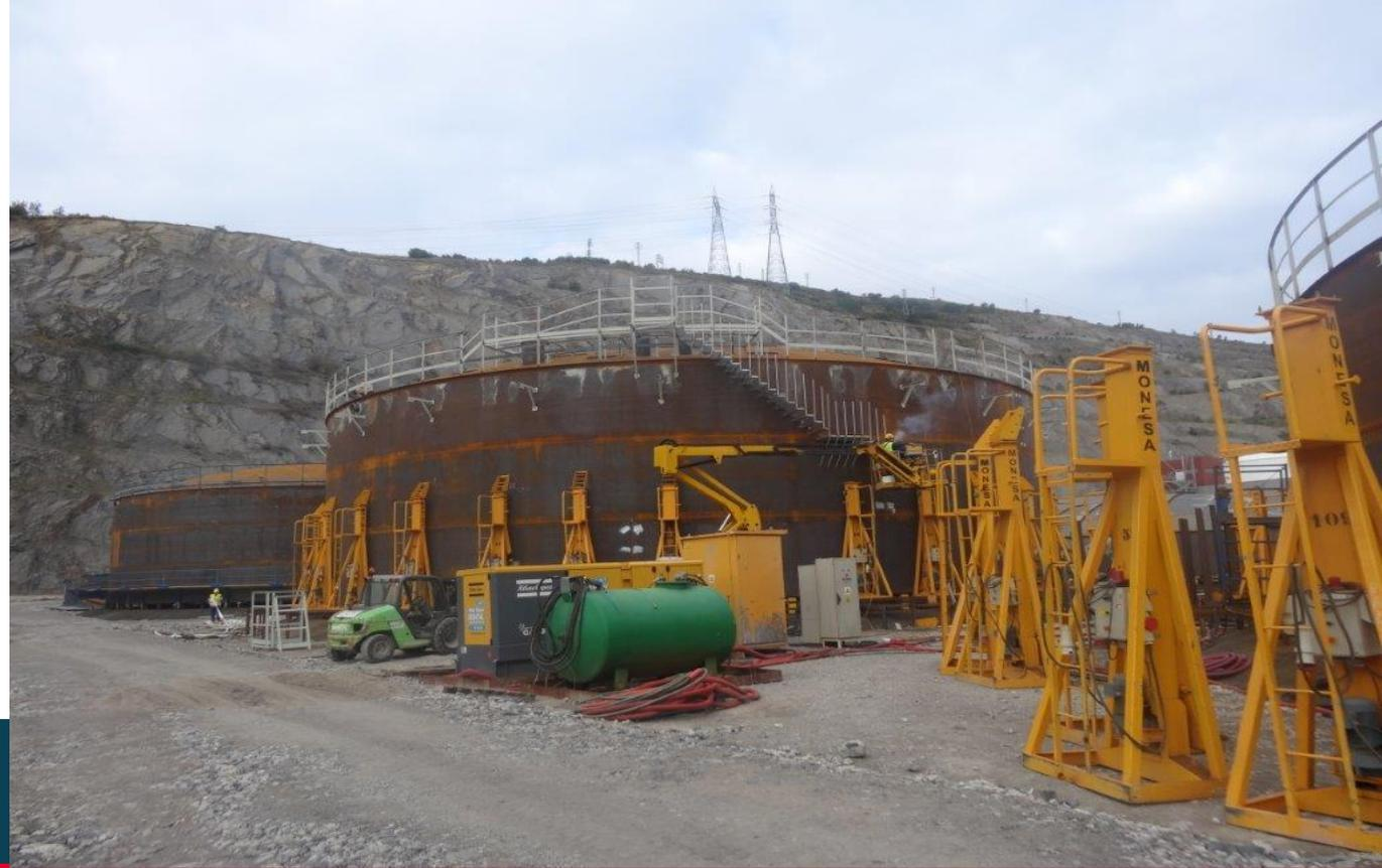
▲ 2 TANQUES de 59,5 m. Ø y capacidad de 35.000 m<sup>3</sup>,
